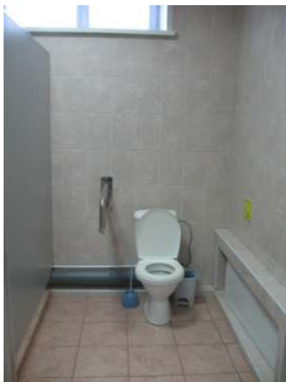
Рис. 10. Туалетная кабинка для лиц с ОВЗ (проведены санитарно-технические работы, установлен откидной поручень)
