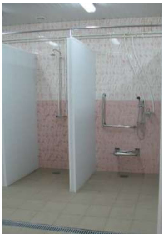
Рис. 9. Душевая (установлены откидные сидения для инвалидов, поручни настенные)
