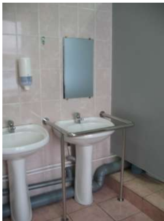
Рис. 11. Раковина, оборудованная поручнем
