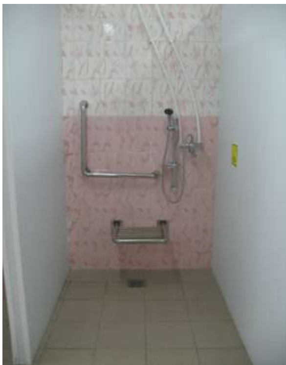
Рис. 9. Душевая (установлены откидные сидения для инвалидов, поручни настенные)
